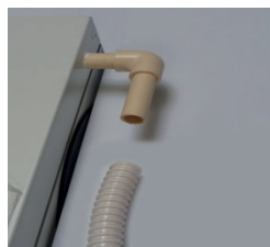
Collegamento dello scarico della condensa inserire la tubazione dritta all'interno dello scarico
